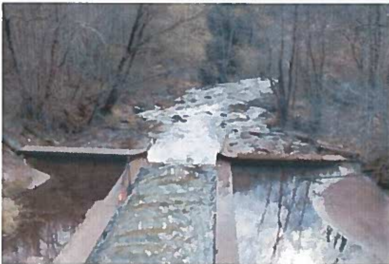
Abbildung 2: Messgerinne Staatsgrenze (Blickrichtung flussab) 2019
