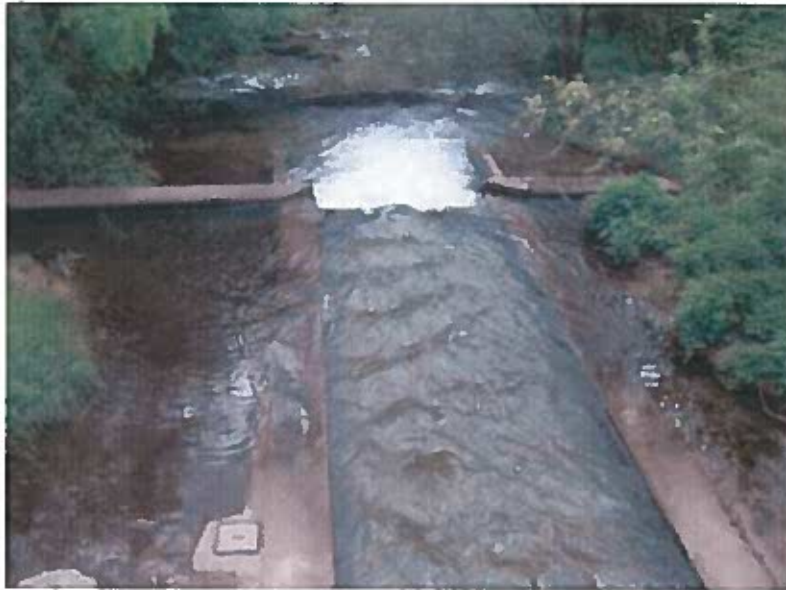
Abbildung 1: Messgerinne Staatsgrenze (Blickrichtung flussab) 2014
