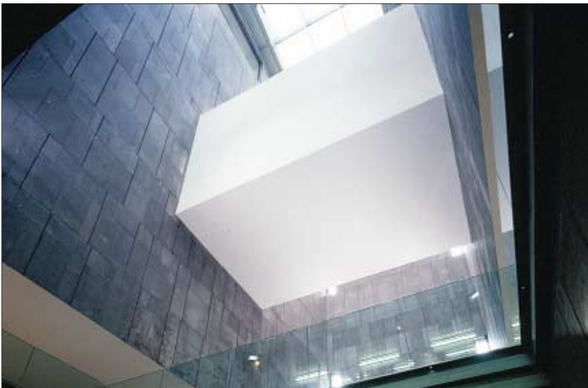
Heimo Zobernig, „Weißer Kubus“ (Umbau, überbrückende Raumverbindung zur Schaffung einer durchgehenden Sonderausstellungsebene)
