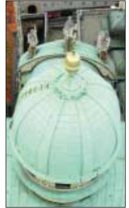
Abb. 4: Graz, Mausoleum, Blick auf die Dachlandschaft
