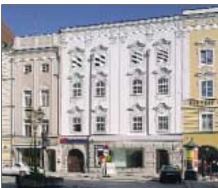
Abb. 6: Wels, Stadtplatz 41, Fassade
