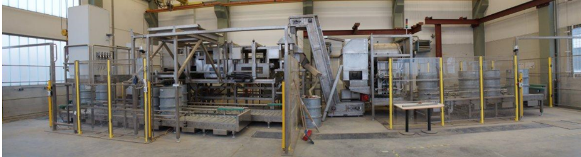
Abbildung 7: Erdmessenanlage (rechts: Materialaufbringung, links: Messung und Separation); Bild: © NES GmbH
