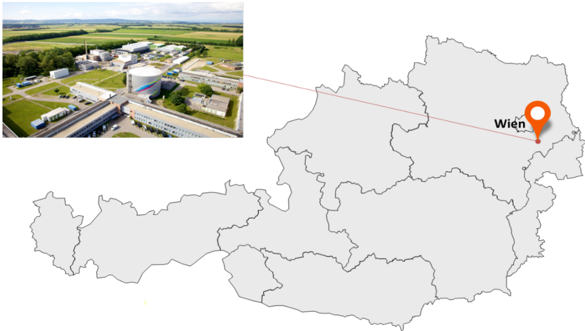
Abbildung 3: Betriebsgelände der NES am Standort Seibersdorf; Bild: © NES GmbH
